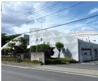
▲リサイクルセンター外観
