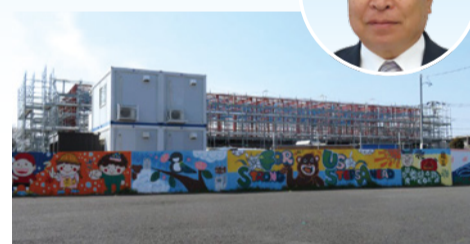
建設が進む片倉跡地
