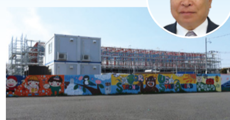
建設が進む片倉跡地
