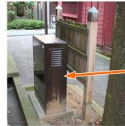
図 2-2-8 地上機器の設置の工夫（看板で目隠しした事例）
