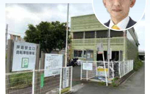
▲拝島駅北口自転車駐車場
