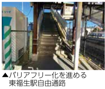
▲バリアフリー化を進める東福生駅自由通路
