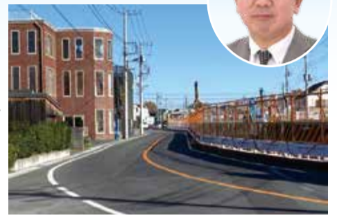
▲工事が行われている多摩橋通り
