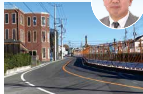
▲工事が行われている多摩橋通り
