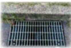
道路に降った雨水を雨水管に集める役目があり、側溝を通じて雨水管に集まった雨水は直接多摩川に流入し
