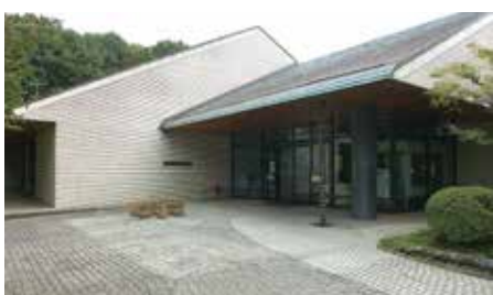
▲改良工事を行う中央図書館
