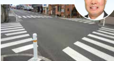
▲歩道に設置されているガードポール
