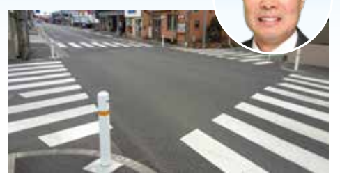
▲歩道に設置されているガードポール
