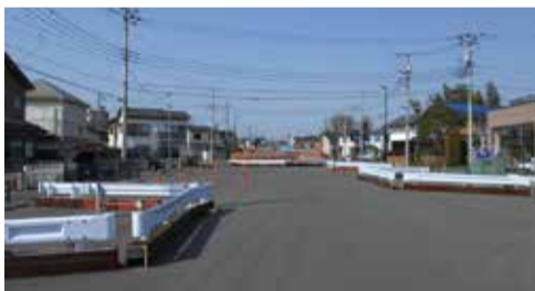
▲整備中の都市計画道路3・3・30号武蔵野工業線
