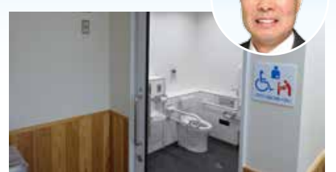
▲バリアフリー化した市営競技場のトイレ
