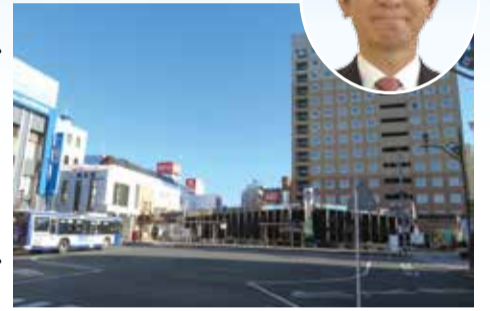
▲福生駅西口の現在の様子
