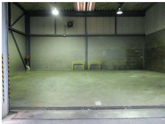
調査場所（リサイクルセンター貯留棟）
