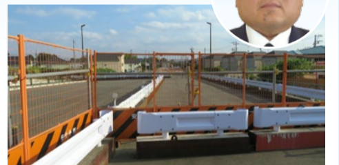
▲延伸工事が行われている産業道路
