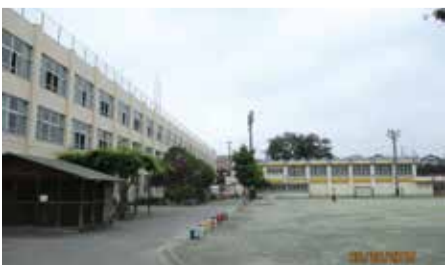
▲増築工事が予定されている福生第三小学校
