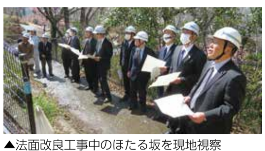
▲法面改良工事中のほたる坂を現地視察
