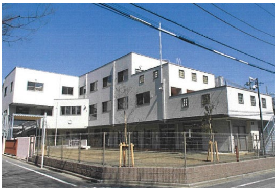
▲建物全体を階段状にし、2階・3階には大きなバルコニーを設置。夏にはプール遊び等も可能。
