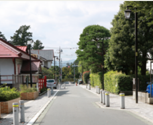
▲無電柱化された宿橋通り
