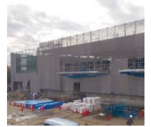
▲建設中の様子 (28年12月)
