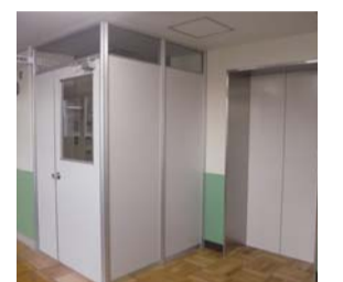
▲第一中学校に設置されたエレベーター
