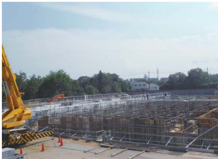
▲順調に建設工事が進む、防災食育センター(熊川1606番地1ほか)
