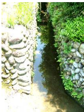
千手院前の空石積みの石垣の様子
