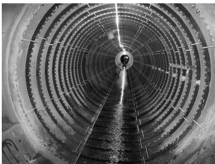
(雨水管渠更生事業)
