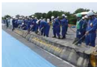
連結水のう工法
