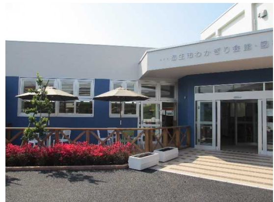
リニューアル工事を行ったわかぎり会館・図書館
