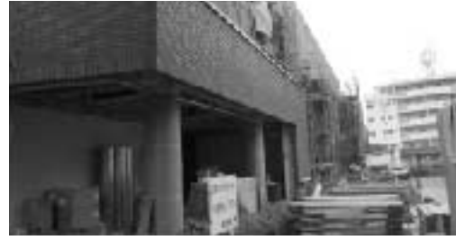
▲大規模改修工事中の市民会館・公民館
