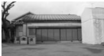
▲千早保育園敷地の中八第1会館
