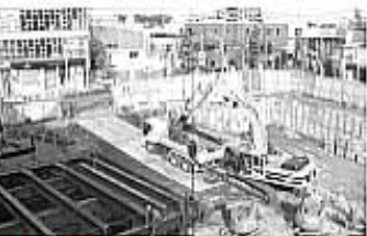
▲市庁舎建設状況
