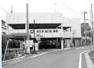
▲指定管理の福生駅西口駐車場
