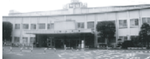
▲建て替え後歯科口腔外科を設置予定の福生病院
