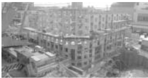
▲現在の庁舎建設状況（H18.10.18）
