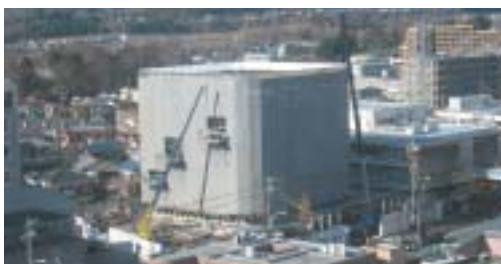
▲庁舎建設状況(H19.1.11)
