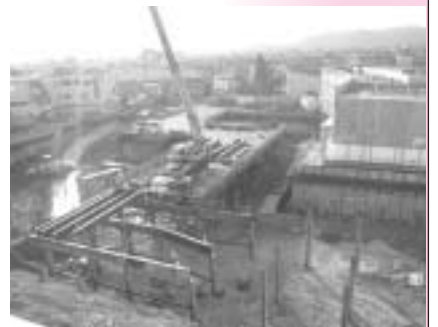
▼建築中の公立福生病院
