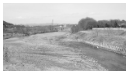
多摩橋より多摩川を望む
