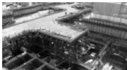
建設中の公立福生病院
