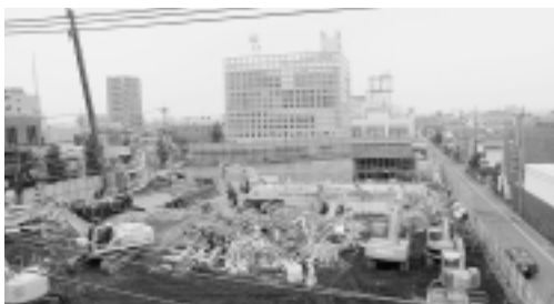
▲庁舎建設第二期工事風景
