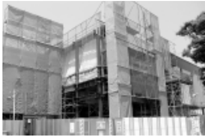
▲拝島駅自由通路工事風景
