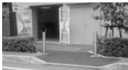
▲段差解消された歩道
