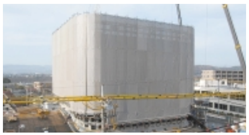
▲新庁舎（第二棟）建設状況（H20.1.9撮影）
