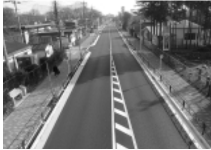
▲整備された都市下水道路 (羽村動物園付近)
