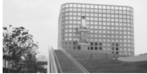
議会議場がある市役所第二棟
