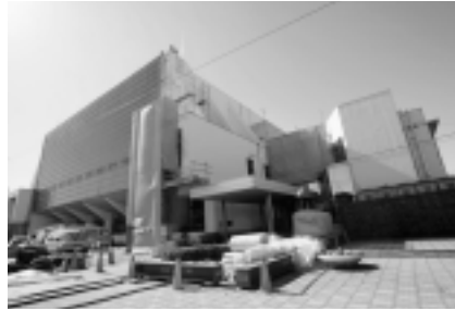
中央体育館の耐震化工事
