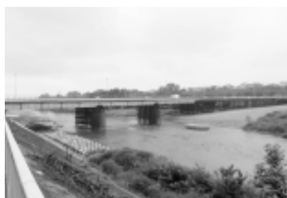
架け替え工事中の永田橋
