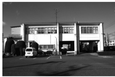
▲事務の受託が廃止される水道事務所
