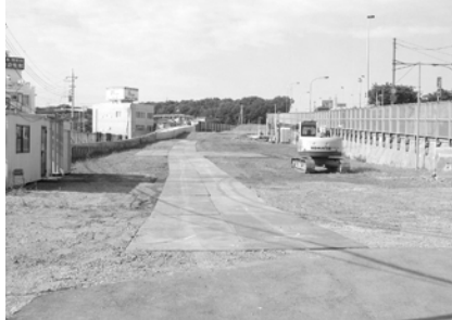
▲国道16号線武蔵野陸橋
