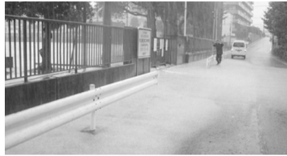
▲福生第二中学校付近の冠水
