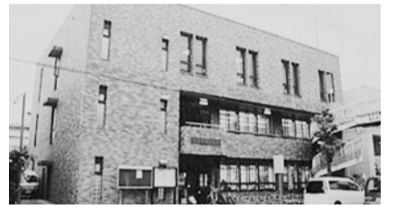
▲商工会館（もくせい会館）
