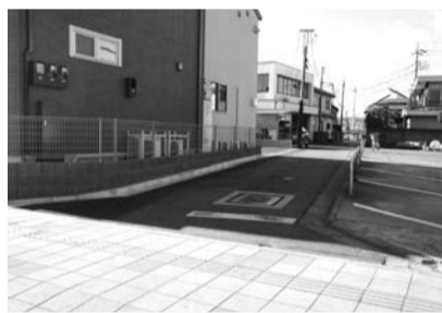
▲整備された狭あい道路
