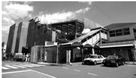
▲工事中の牛浜駅
