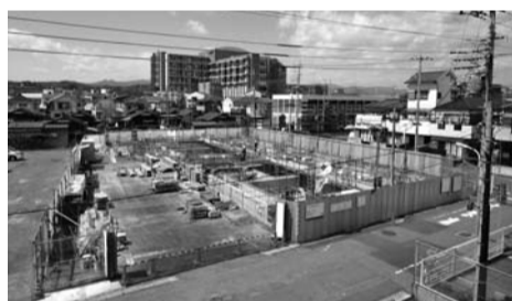
▲建設中のすみれ保育園
