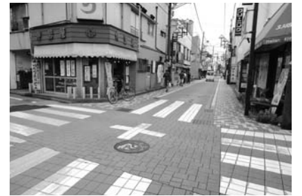
▲銀座通りのインターロッキング舗装
