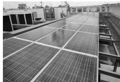
▲庁舎屋上のソーラーパネル
