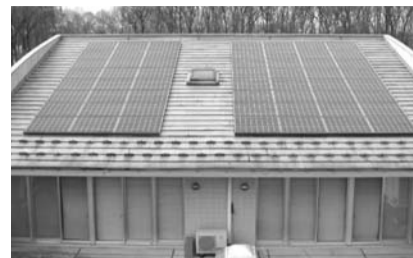
▲リサイクルセンターの太陽光パネル
