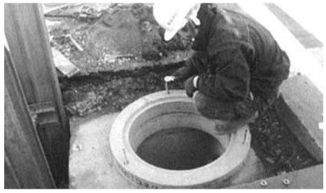
▲汚水ます設置工事
